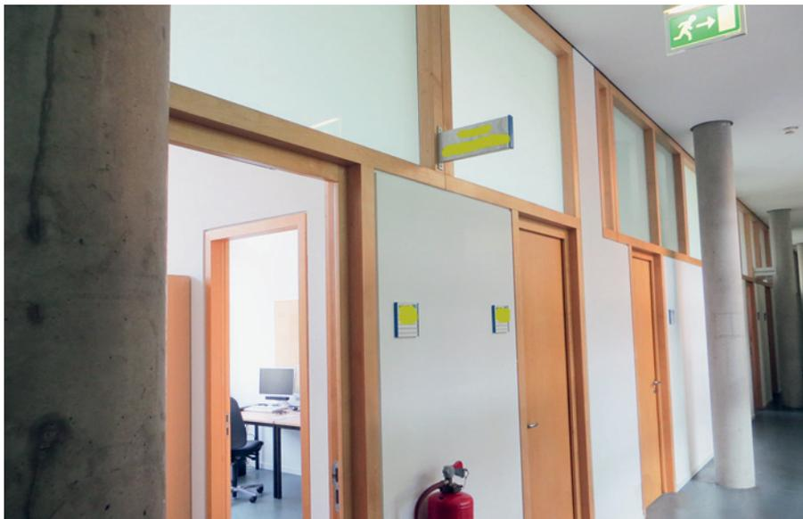
Abb. 3: Für diese Trennwände mit Brandschutzverglasungen lagen keine Verwendbarkeitsnachweise oder andere Unterlagen vor. Der Feuerwiderstand konnte aber durch Vergleich mit ähnlichen Produkten mit hoher Sicherheit ermittelt werden.
