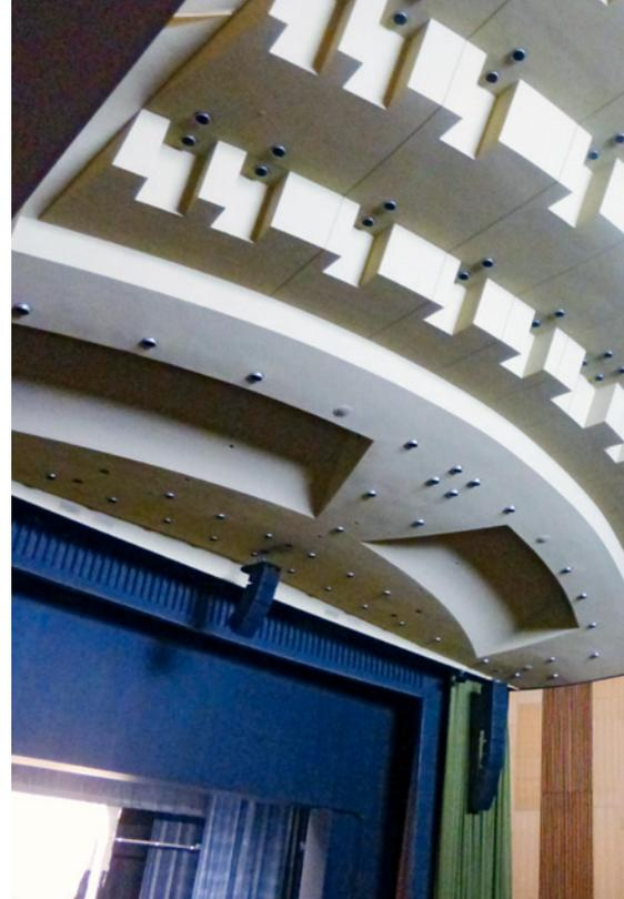
Abb. 7: Verbliebene bauzeitliche Decke und Holzbekleidungen im Großen Saal
