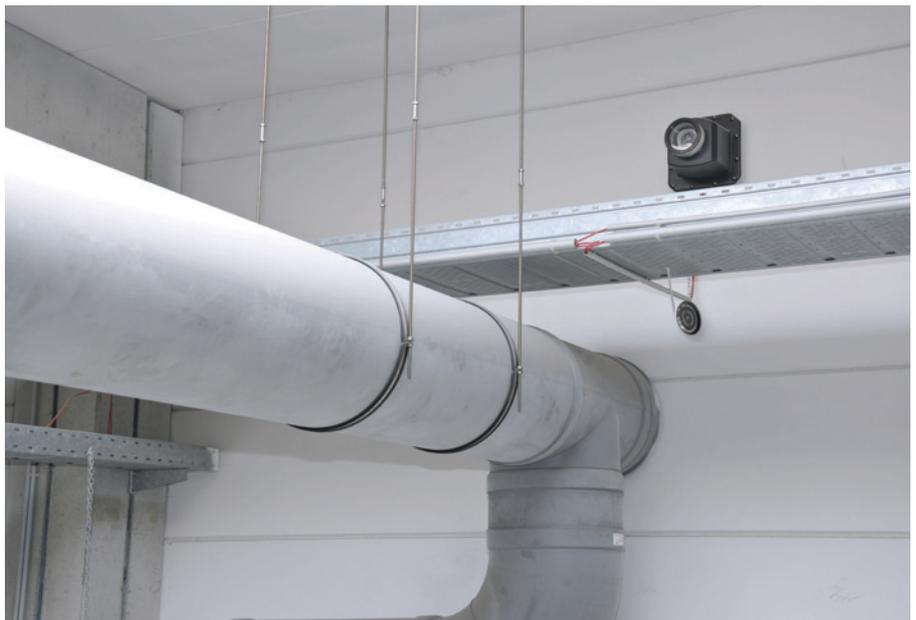
Abb. 3: Die 13 in der Halle befindlichen Hekatron Iliia Dust Pro S/EMelder sind auf die höchste Empfindlichkeitsstufe parametrieren und lösen dennoch keine Fehlalarme
